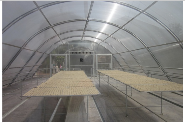
ห้องอบพลังงานแสงอาทิตย์ ก่อนนำไปทอด
