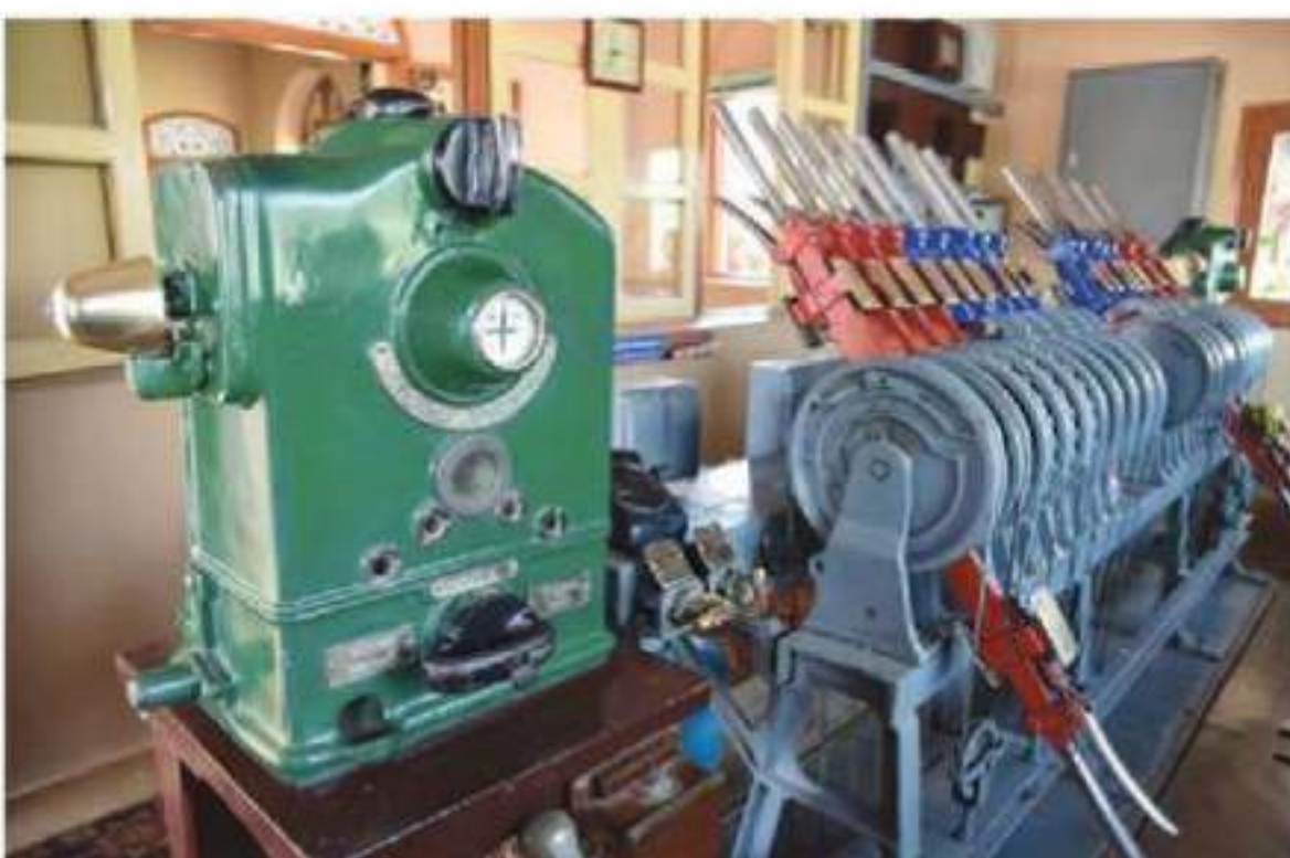
อุปกรณ์ให้ขทางรถไฟจากอินเดีย อายุร่วมร้อยปี ที่สถานีบ้านปินยังใช้อยู่
